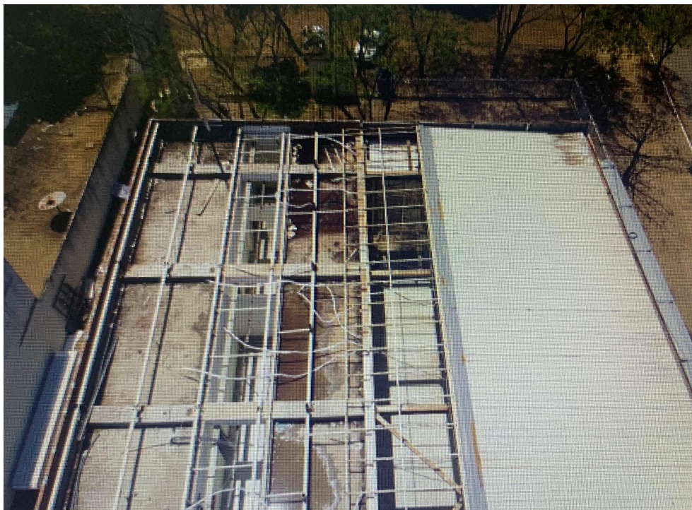
Remoção de Telhas, Calhas, Perfis danificados e Estrutura do Telhado (100% do serviço concluído)
