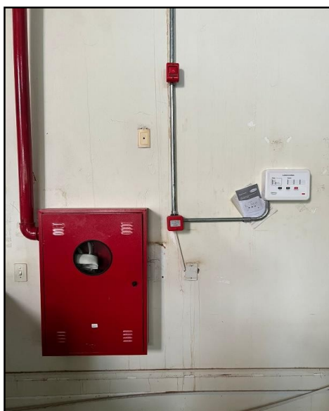
Imagem 04 e 05: serviço de execução de hidrante de alarme e hidrante de recalque
