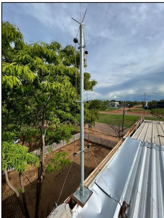
Imagem 06 e 07: instalação para-raio tipo Franklin e quadro de aterramento
